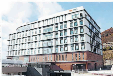
こころホスピタル草津が新たに整備した本館
